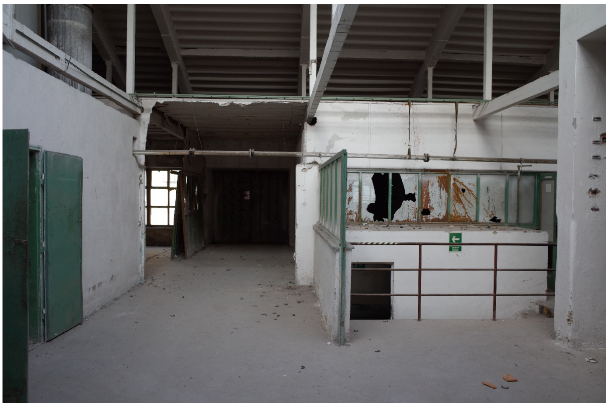
16. Patro, bourané konstrukce příček a podhledů
