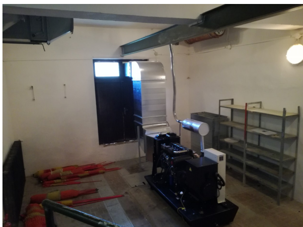
Umístění dieselagregátu v objektu D (2.NP), napojení na přísávání vzduchu a napojení na odtaž spalin; venkovní pohled se současným zděným komínem (bude nahrazen novým nerezovým)
