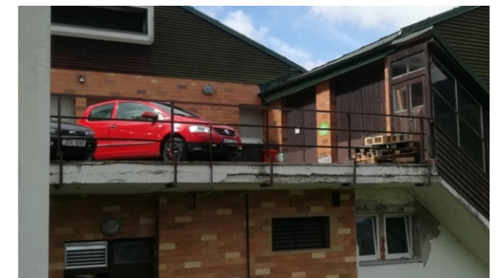
NÁHRADA ZA TOTO ZÁBRADLÍ
