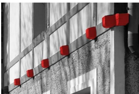
obr. SO-02 - vzorkovat dřevěné prvky krovu - podhledy, dřevěné části štítů, severní štít (doplnění), aj.
