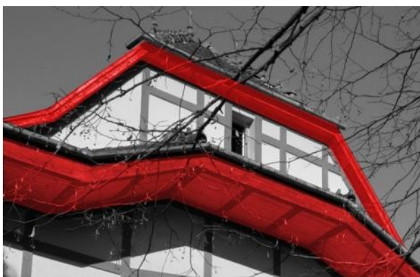
obr. SO-02 - vzorkovat dřevěné prvky krovu - podhledy, dřevěné části štítů, severní štít (doplnění), aj.
