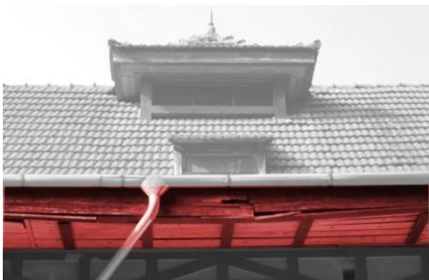
obr. SO-02 - předpokládané a ideální místo k vzorkování omítek
